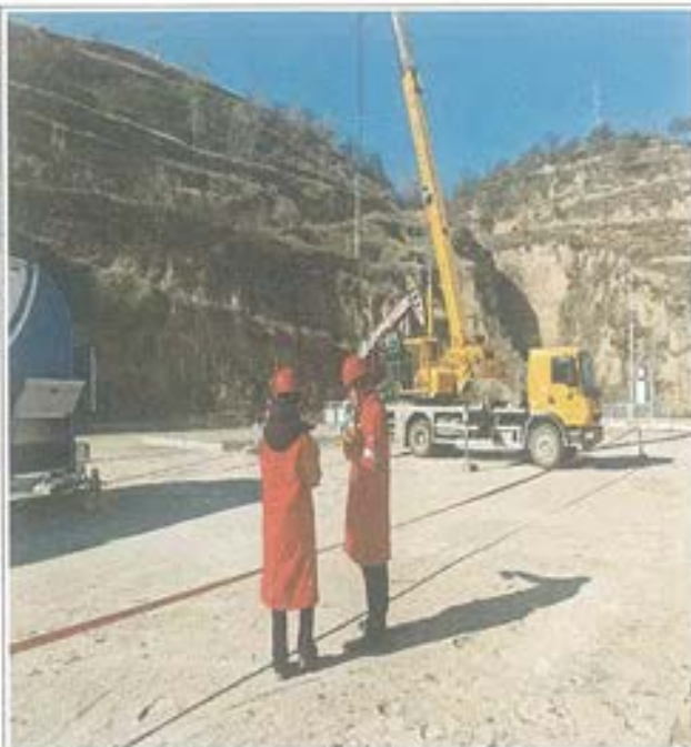
中子管测井工作场所
